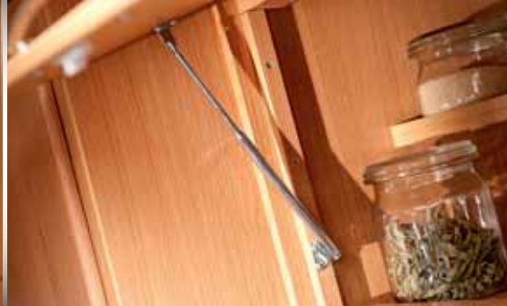
Nye metalholdere på overskabslåger
